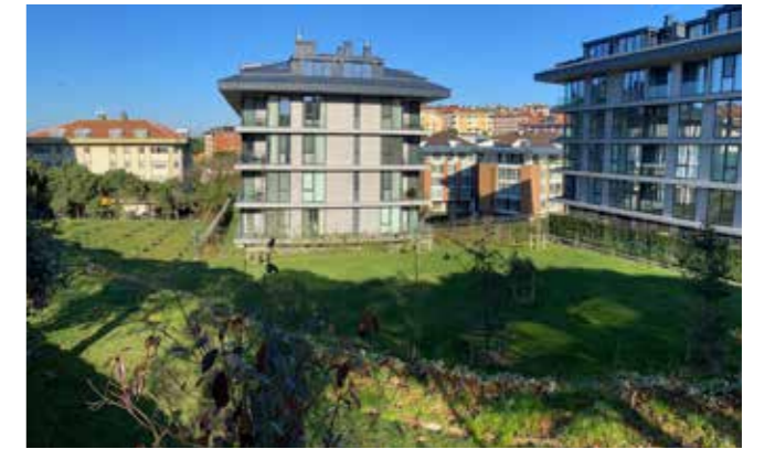
Zekeriyaköy Mahallesi 109 Ada, 5 Parsel Parkı
