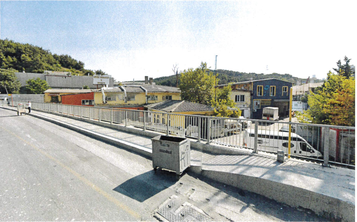
Görsel.6. 10642 ada 2 parselden görünüm
