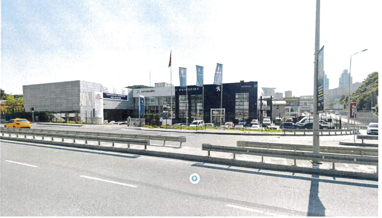
Görsel.7. 10642 ada 2 parselden görünüm
