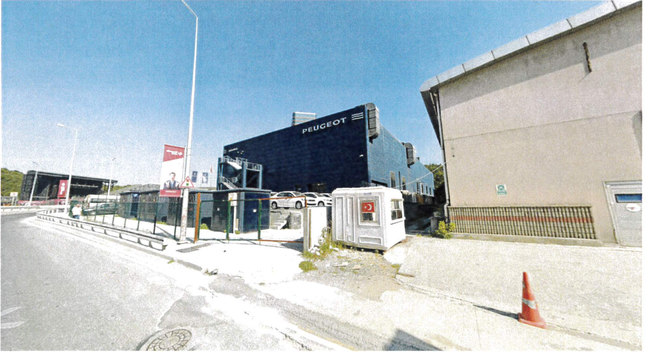
Görsel.8. 10645 ada 2 parsel ve kısmen 3 parselden görünüm
